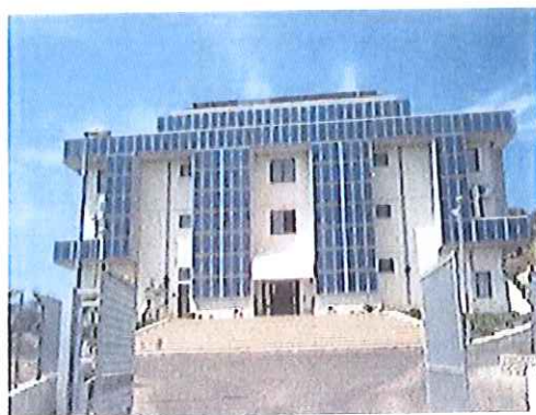
Figura 1: Impianto fotovoltaico sulla facciata della System House S.r.l.
